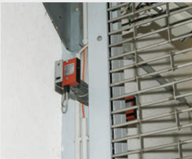
Dispositif de sécurité de grille enroulante
